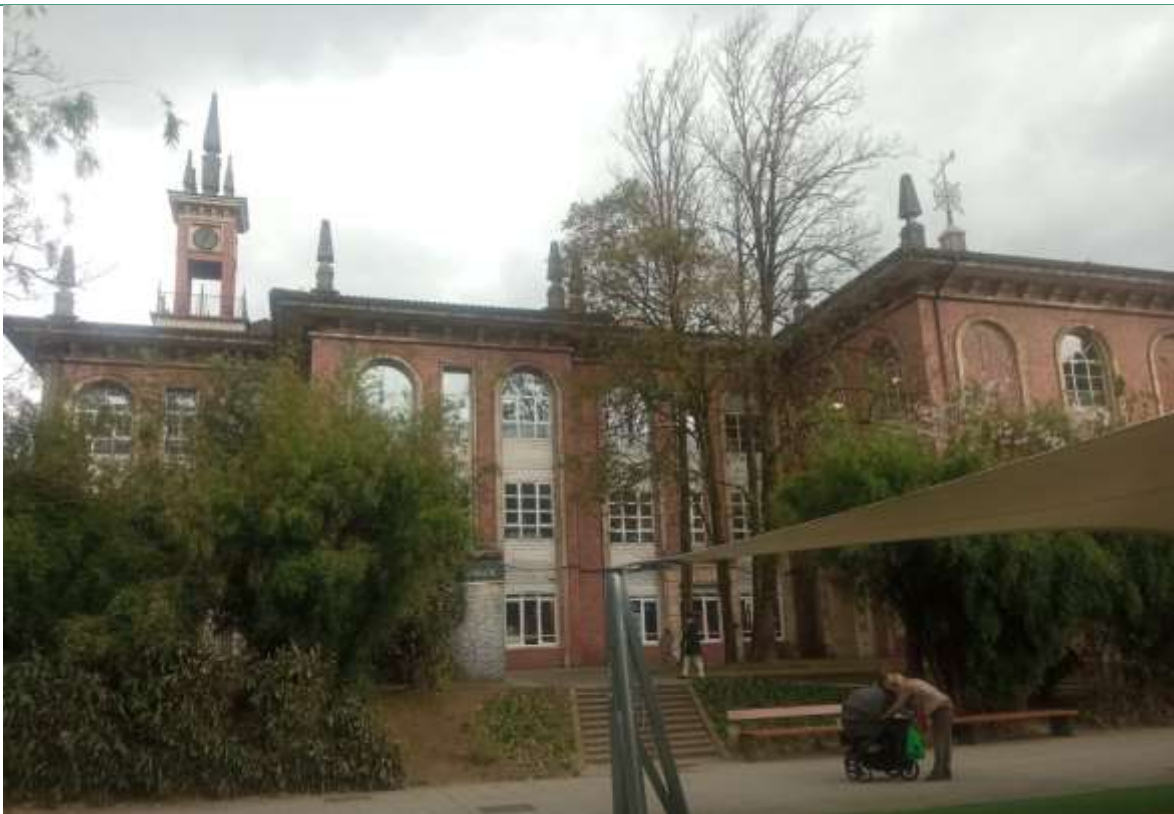
04. Ikuspegi orokorra Vista general
