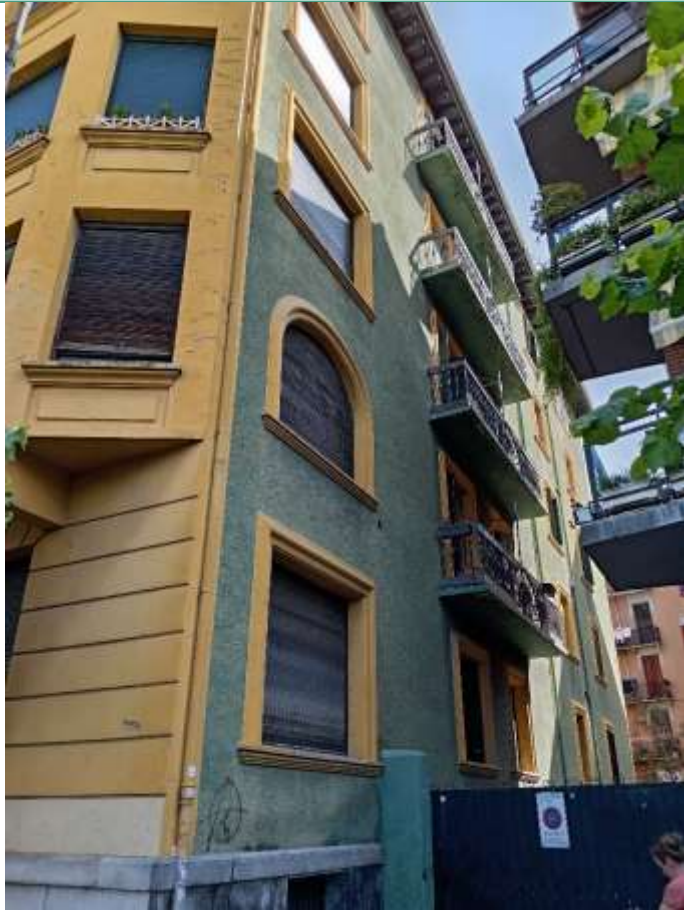
03. Ikuspegi orokorra alboko fatxada HE Vista general de la fachada lateral SE
