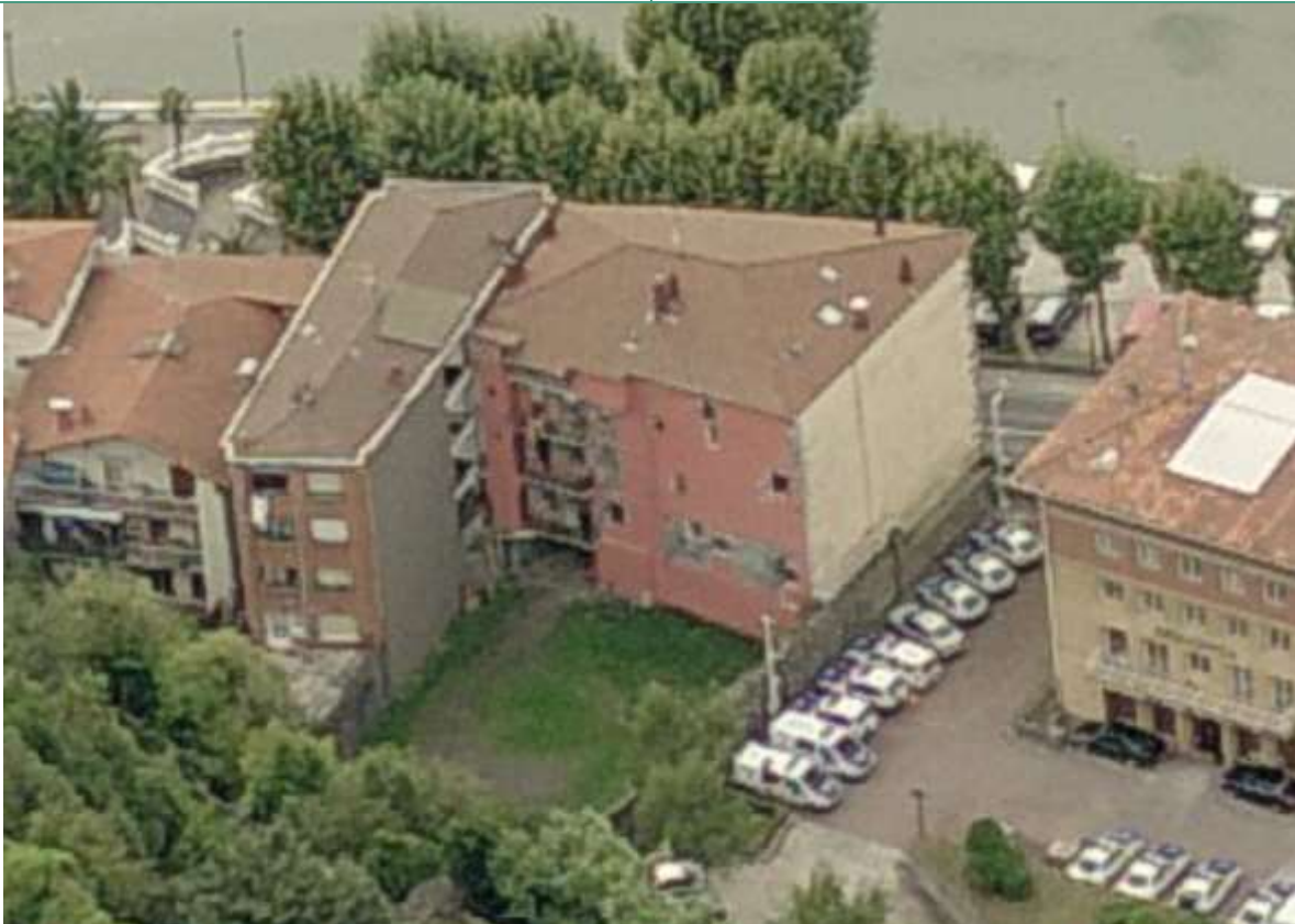
05. Ikuspegi orokorra atzeko eta alboko fatxadak. Vista general de las fachadas trasera y lateral
