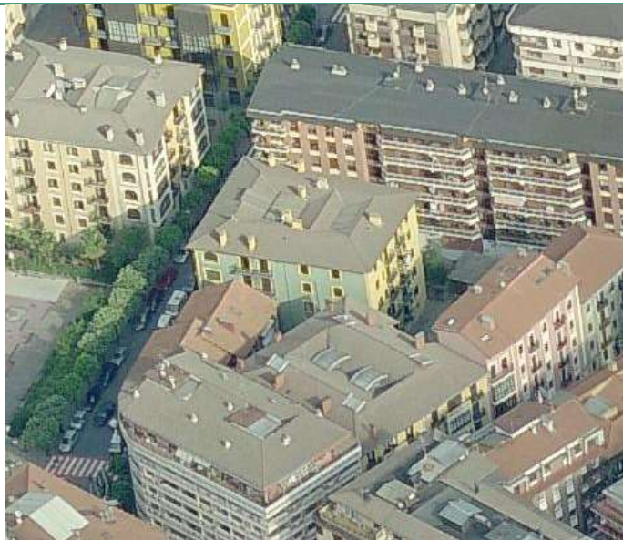
04. Ikuspegi orokorra patioetik (2009) Vista general desde el patio de manzana
