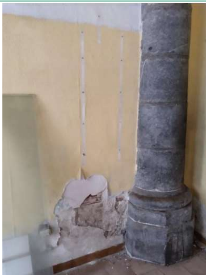
04. Barruko zutabe zirkularra Detalle del pilar circular interior
