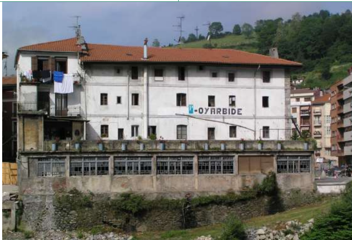
05. Ibai aldeko fatxadaren (E) ikuspegi orokorra alboko eraikinak kendu aurretik (2023) Vista general de la fachada hacia el río (E) antes del derribo de las edificaciones anexas (2023).
