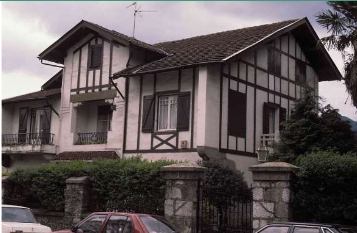
03. Birgaitu aurreko eraikinaren ikuspegi orokorra kanpoko itxiturarekin Vista general del edificio antes de la reforma con el cierre perimetral.
