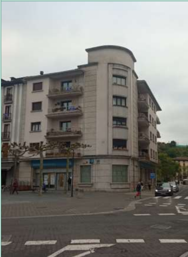
04. Ikuspegi orokorra Vista general
