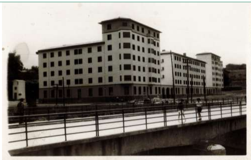
02. Ikuspegi orokorra Vista general
