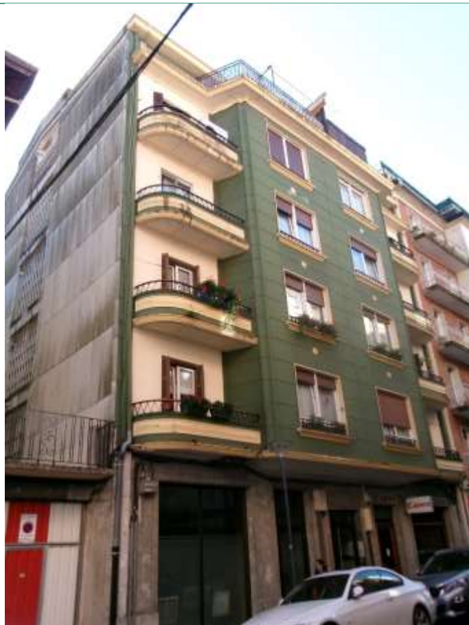
02. Ikuspegi orokorra Vista general
