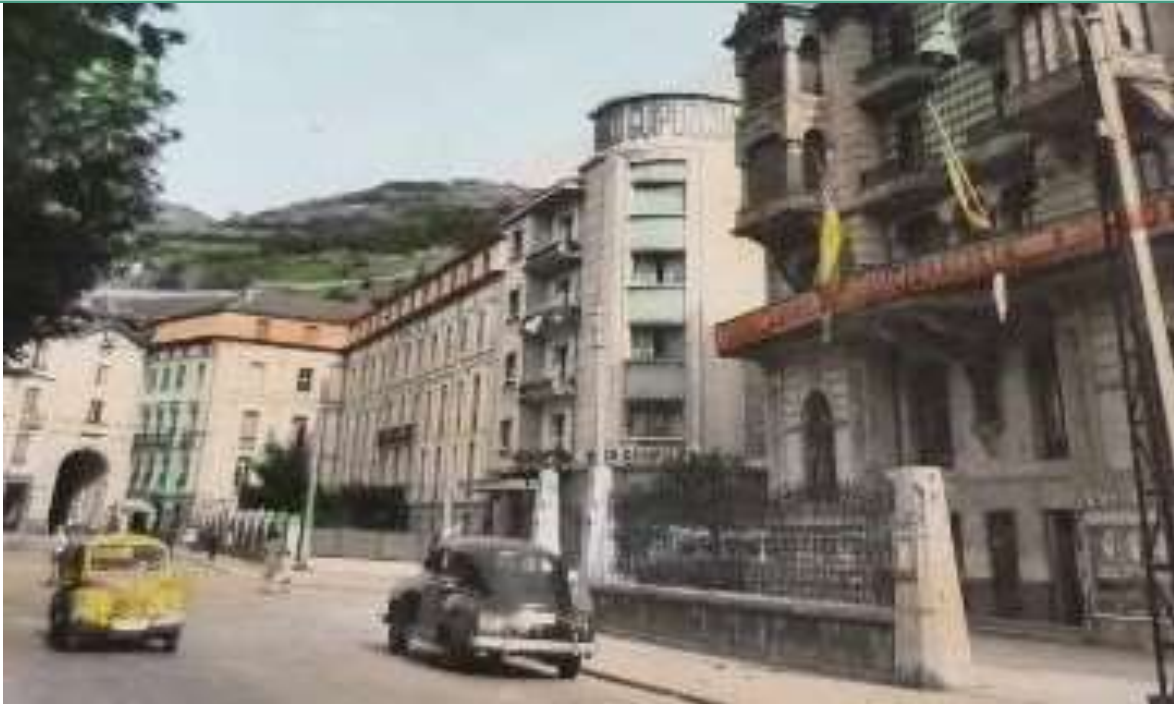
03. Ikuspegi orokorra Vista general
