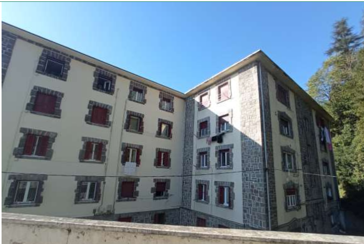
04. Ikuspegi orokorra Vista general
