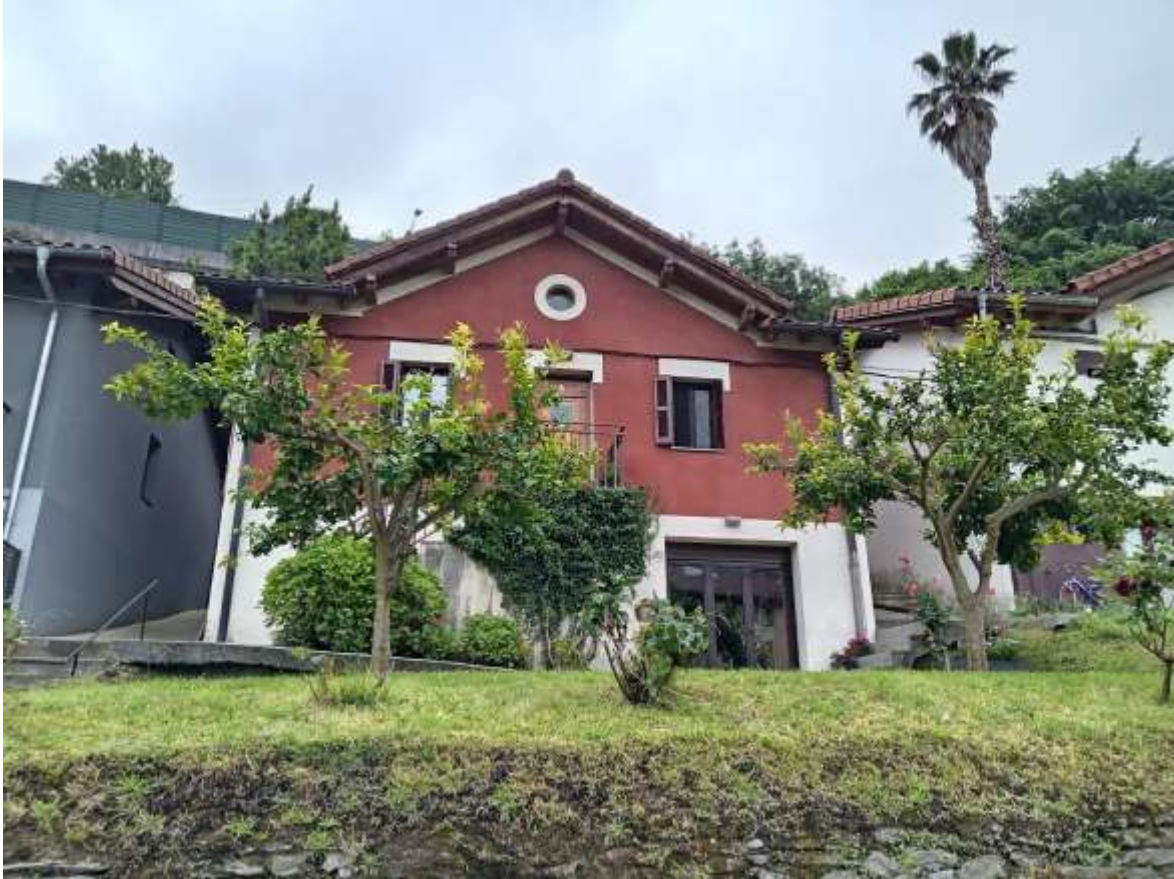
05. Ikuspegi orokorra Uzturre 8 Vista general Uzturre nº8
