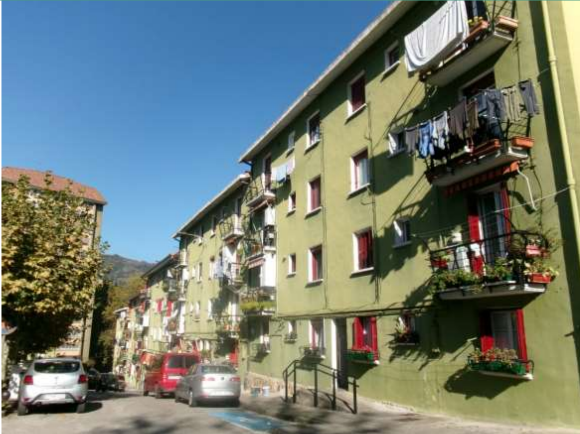
03. Ikuspegi orokorra Vista general
