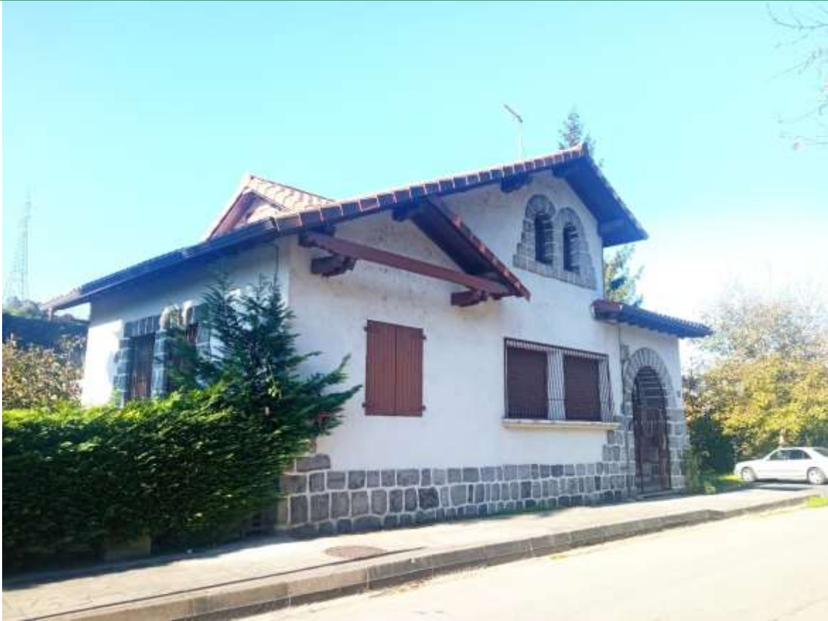
03. Ikuspegi orokorra Vista general
