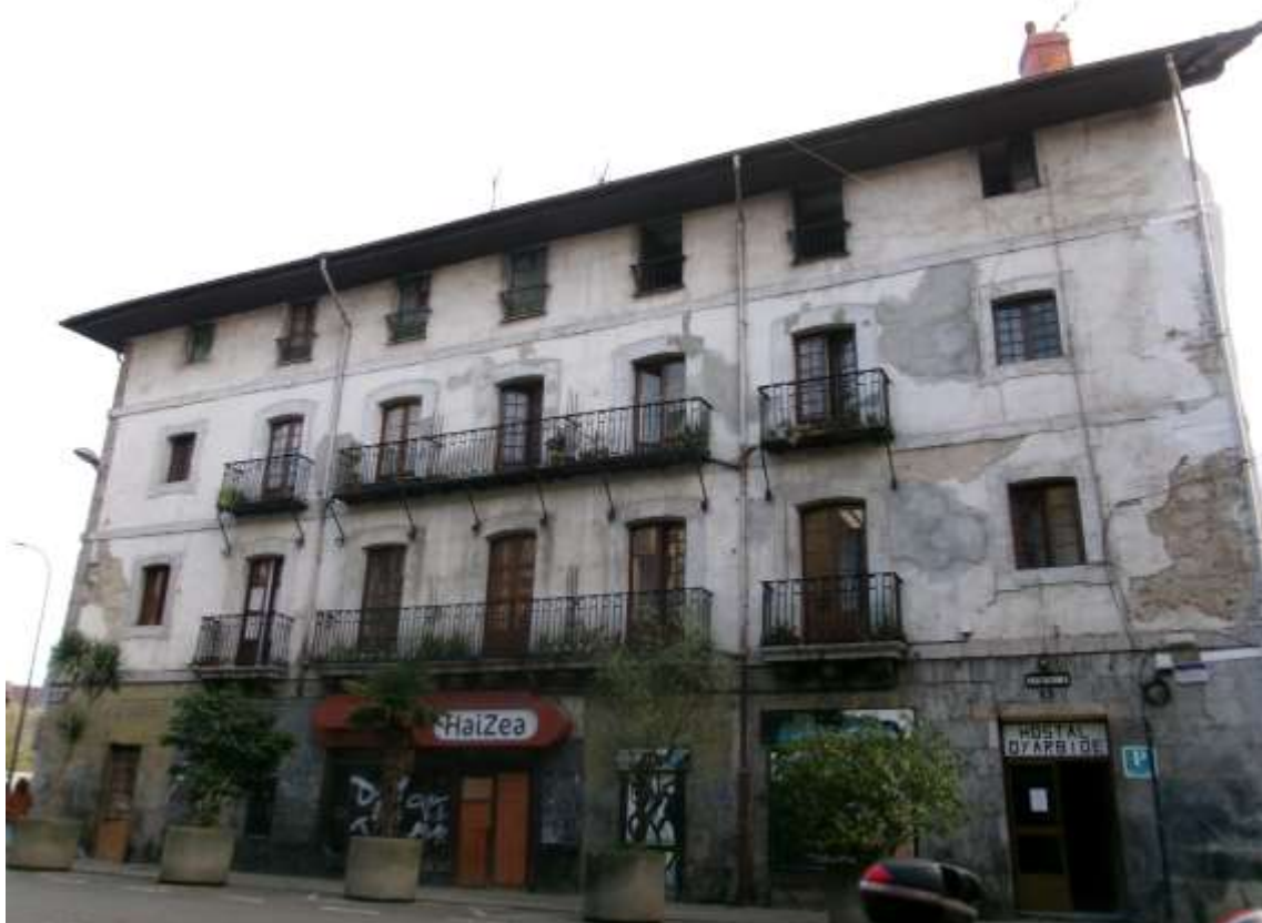
02. Fatxada nagusiaren ikuspegi orokorra Vista general de la fachada principal
