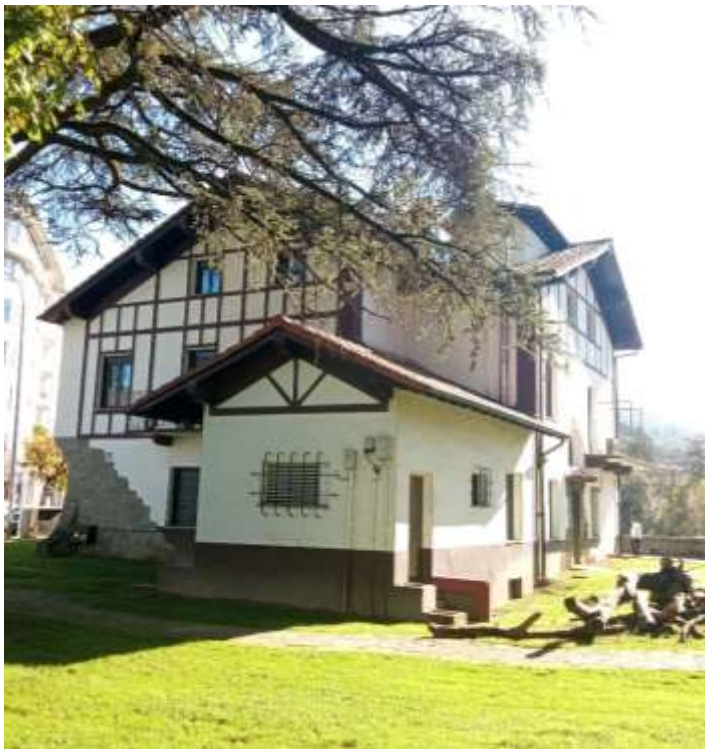
04. Ikuspegi orokorra, atzealdeko fatxada Vista general de la fachada trasera
