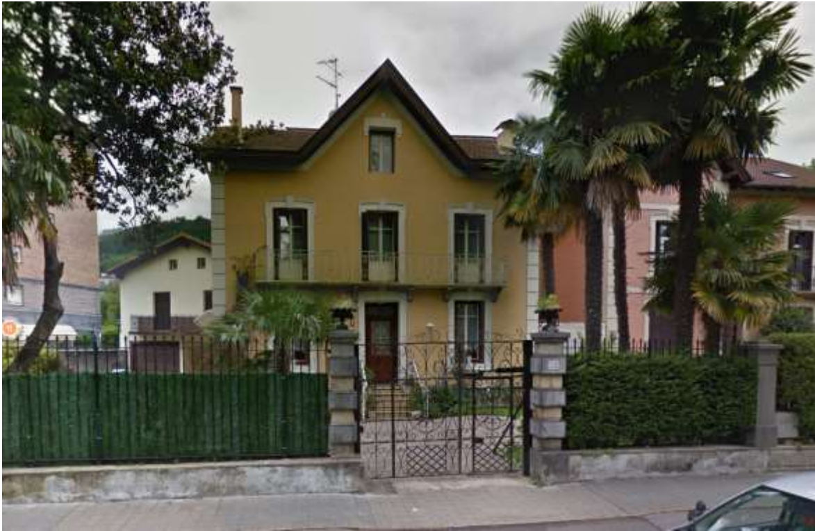
03. Ikuspegi orokorra Vista general
