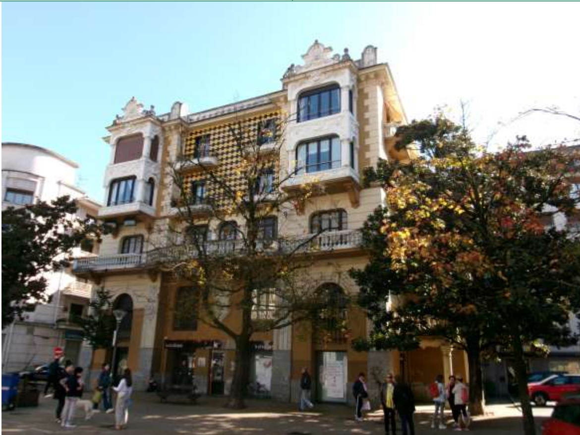
04. Ikuspegi orokorra fatxada nagusia Vista general de la fachada principal
