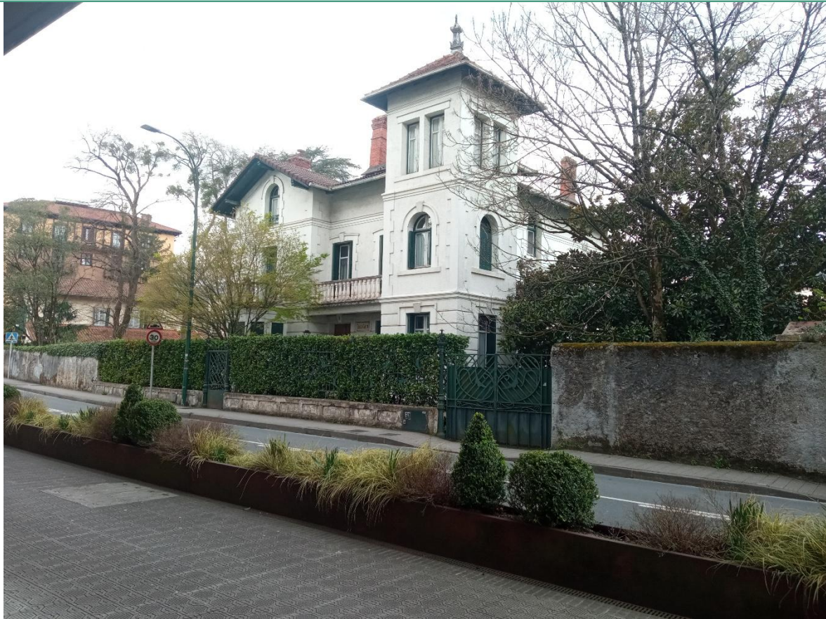
01. Ikuspegi orokorra kaletik Vista general desde la calle
