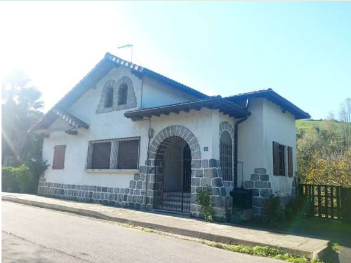
02. Ikuspegi orokorra Vista general
