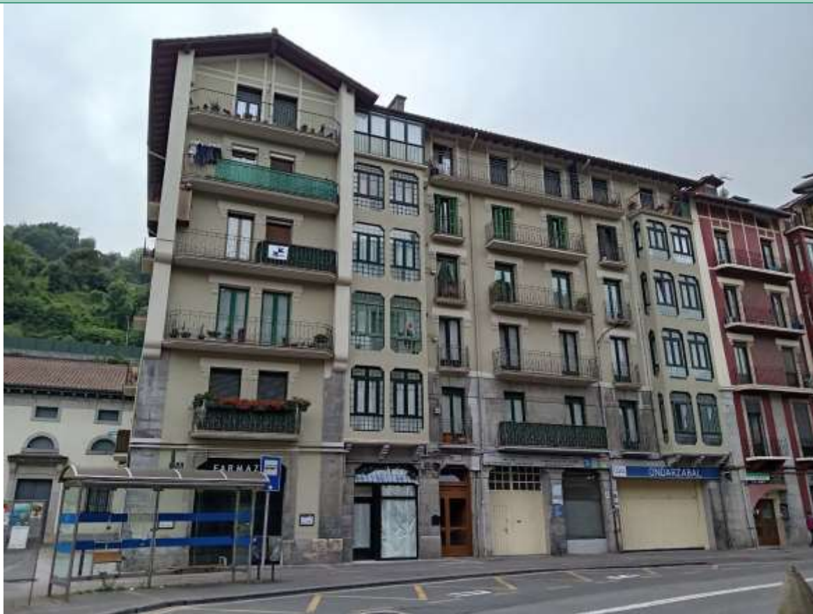
05. Ikuspegi orokorra Larramendi kalea 6 (Azkarate etxea) Vista general nº6
