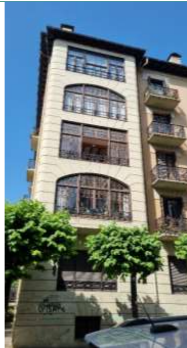
05. Gaur egungo arotzeriak, jatorrizko diseinuarekin alderatuz. Estado actual de las carpinterías, respecto a las originales.
