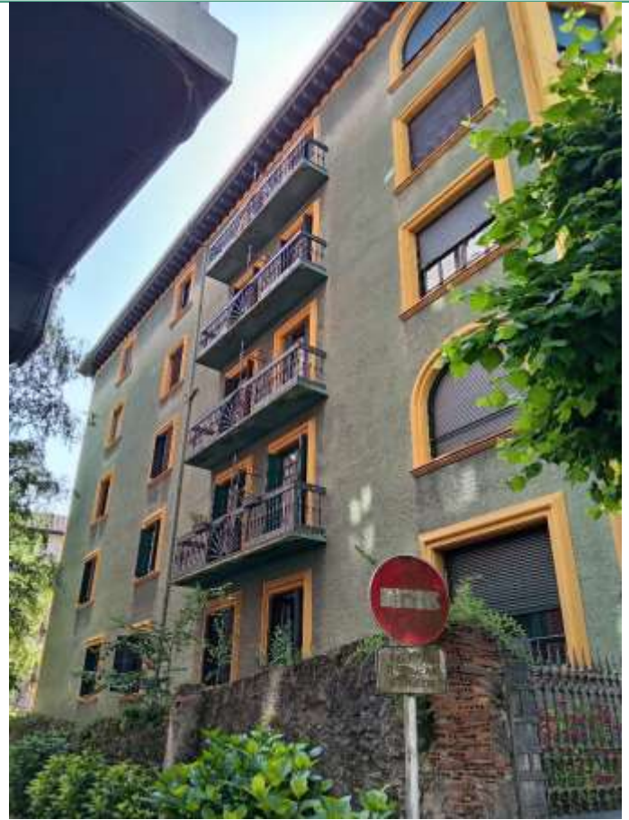
04. Ikuspegi orokorra alboko fatxada IM Vista general de la fachada lateral NO
