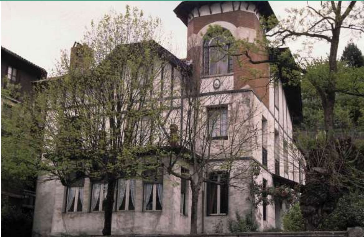
03. Aurretiko ikuspegi orokorra Vista general previa
