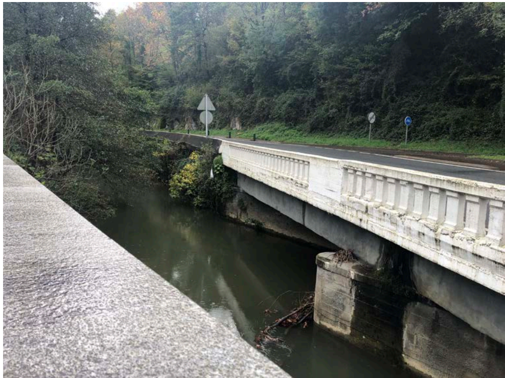
Foto 2: Puente PK 1076,833m
