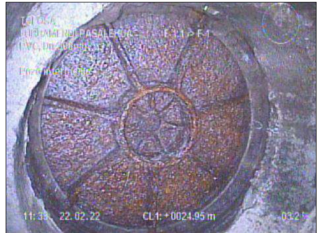
Fotografía: 6_2b 24,9m, Pozo intermedio
