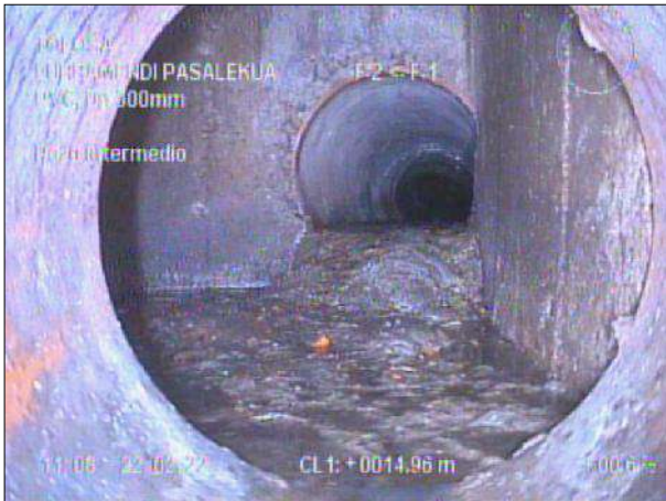
Fotografía: 2_2a 15,5m, Pozo intermedio
