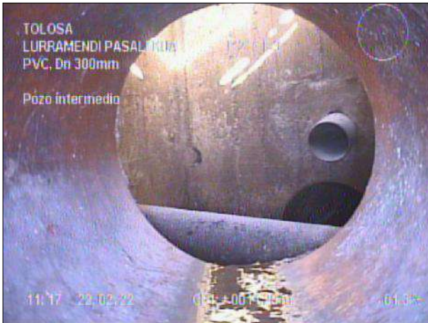
Fotografía: 4_2a 11,9m, Pozo intermedio
