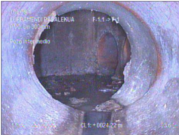
Fotografía: 6_2a 24,9m, Pozo intermedio
