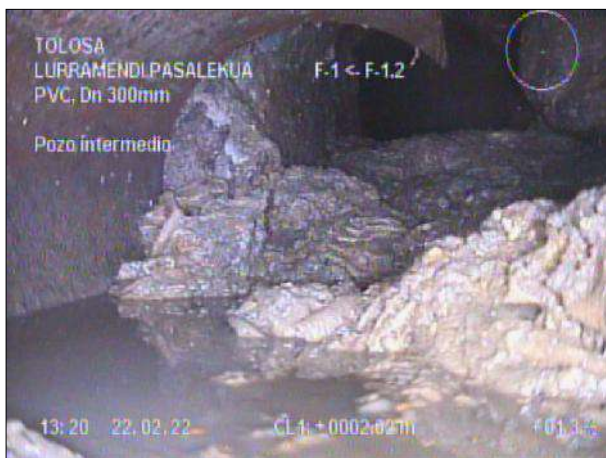
Fotografía: 13_3a 2,9m, Pozo intermedio
