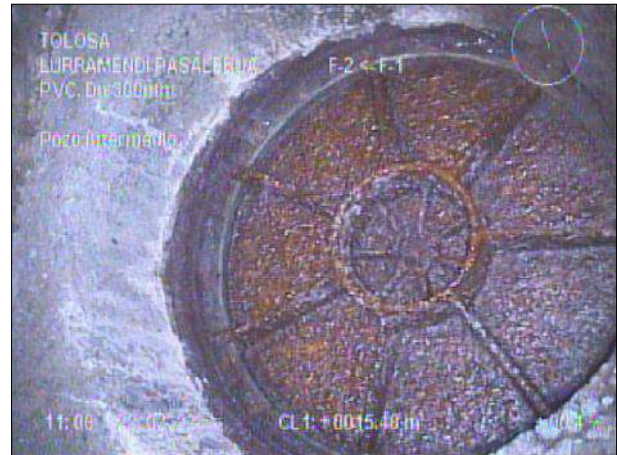
Fotografía: 2_2b 15,5m, Pozo intermedio
