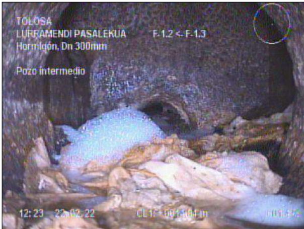
Fotografía: 10_4a 15,5m, Pozo intermedio
