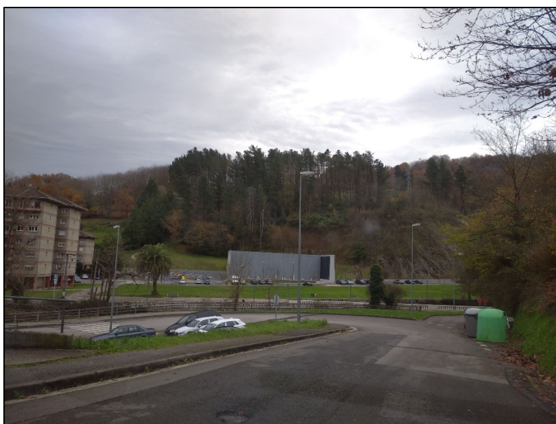
El ámbito 20.1 Papelera Amaroz, continuación del actual barrio de Amaroz, se ubica en la unidad de paisaje agrario en dominio fluvial.
